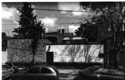
Imagen 2. Vista de la construcción preexistente de 2 niveles (Fuente Google Maps año 2008).
