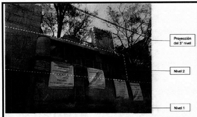
Imagen: Inmueble con 2 (dos) niveles con una altura de 6.2 metros y la construcción de un tercer nivel con 2.5 metros de altura, desplantado únicamente en una porción del segundo nivel
