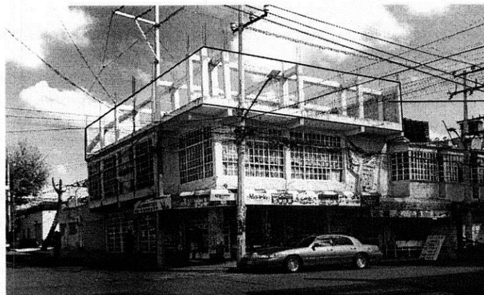
Imagen 2. Se observan los trabajos de ampliación que se realizaron hasta el momento en el predio. Fuente: Reconocimiento de hechos 21/10/2021
