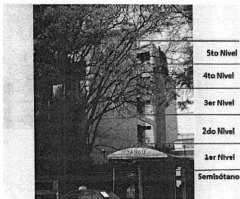
Imagen 1: se observa la construcción de 5 niveles
