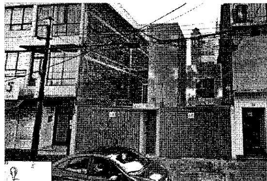
Imagen 2 Marzo de 2015, se observa el mismo Inmueble visto en 2011.
