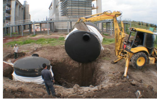
Colocación de los tinacos industriales
