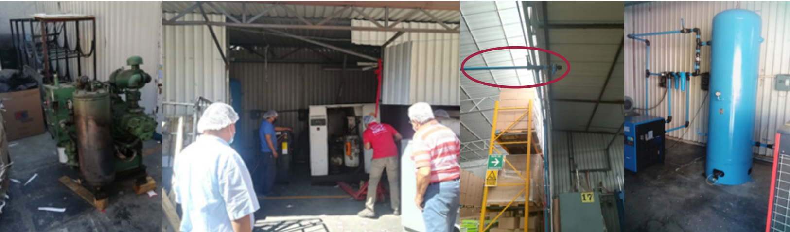
Desinstalación de antiguo compresor.
